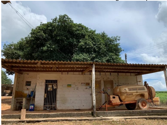
Figura 13: Local onde são armazenados os insumos agrícolas e pista de abastecimento.
