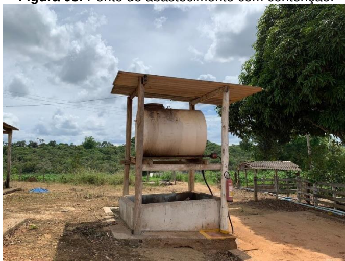
Figura 08: Ponto de abastecimento com contenção.
